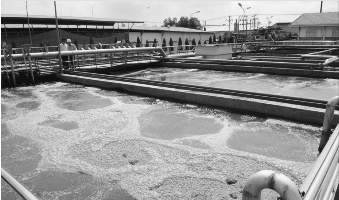
Đa số các khu công nghiệp ở nước ta vẫn hoạt động trong khi chưa đầu tư xây dựng hệ thống xử lý nước thải tập trung Ảnh: TS
